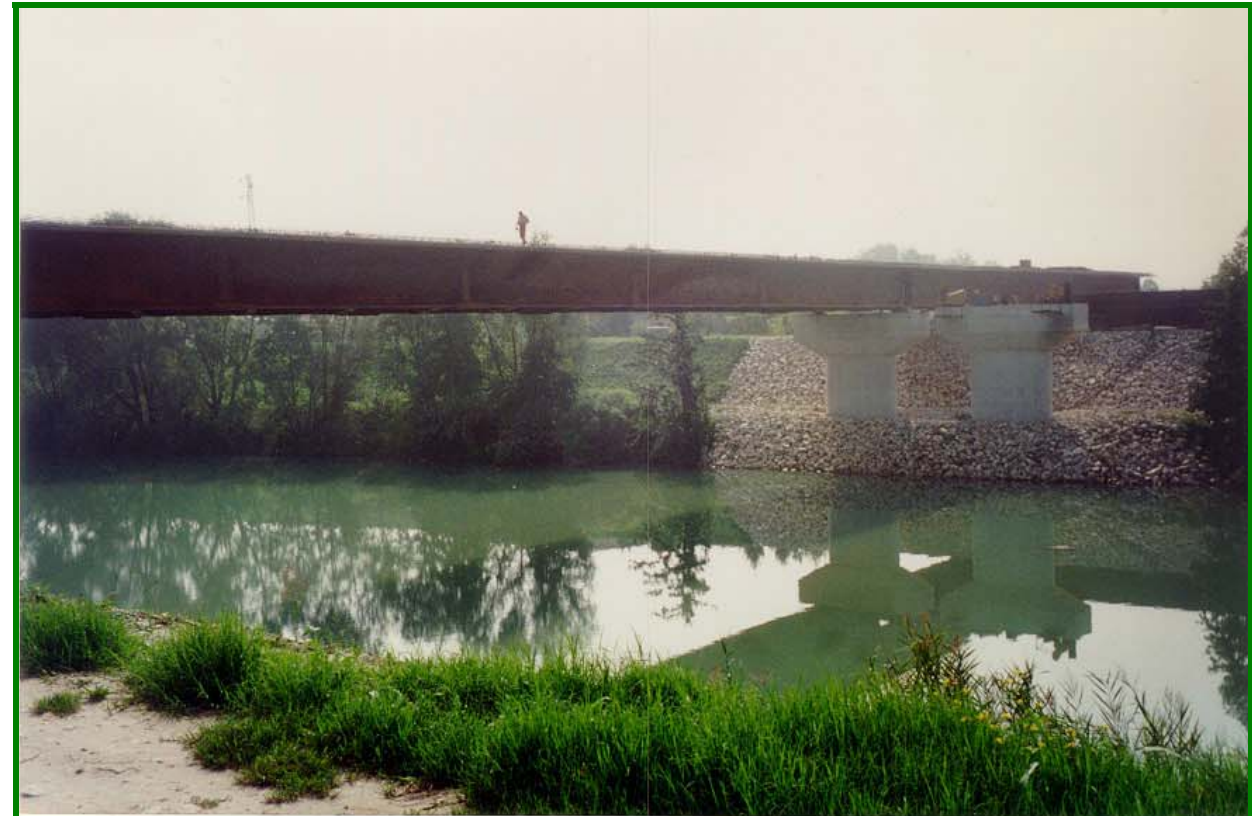
Ponte sul Brenta : nr. 3 campate da 53.00 + 75.00 + 55.00 metri
